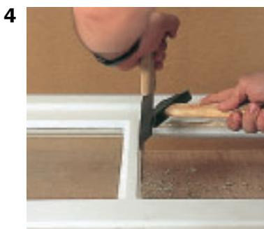
4. Lorsque le mastic est très dur, utiliser un couteau à démastiquer et un marteau en veillant à ne pas endommager le bois de la feuillure.
