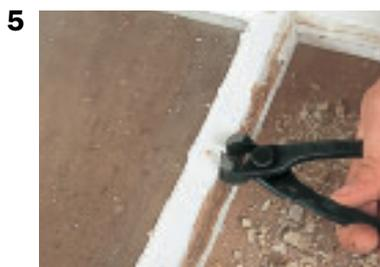
5. Arracher à la tenaille les anciennes fixations. Il peut s'agir de pointes ou de fixations en triangle ou en losange.
