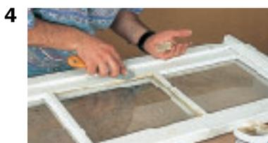
5. Lisser le solin de mastic en appuyant fermement le couteau de vitrier avec un angle de 45°. Tirer lentement le couteau d'un bout à l'autre.
