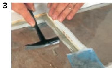
4. Déposer du mastic dans l'angle formé par la vitre et la feuillure, de façon à réaliser un solin triangulaire tout autour du vitrage.
